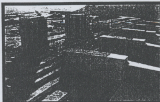
شکل ۵ - قالب بندی درز قائم اجرایی در پایه میانی سرریز
